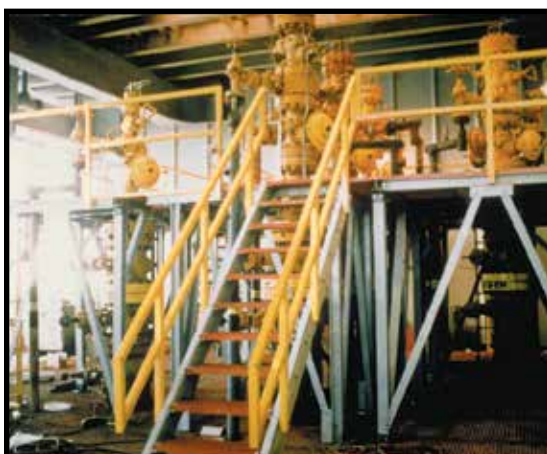
La estructura de soporte y los barandales de tubo cuadrado Dynaform brindan un elevado nivel de resistencia a la corrosión para esta plataforma offshore.
